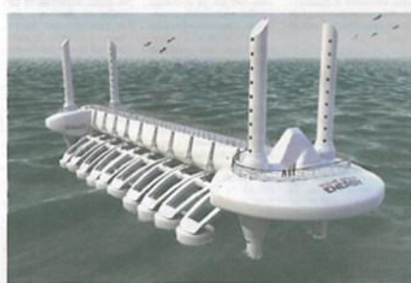
Det prøvanlæg, Wave Star Energy A/S vil opsætte ved Roshage Mole i sommer, vil svare til "led" af dette 500 MW kraftværk. Grafik: Wave Star Energy
